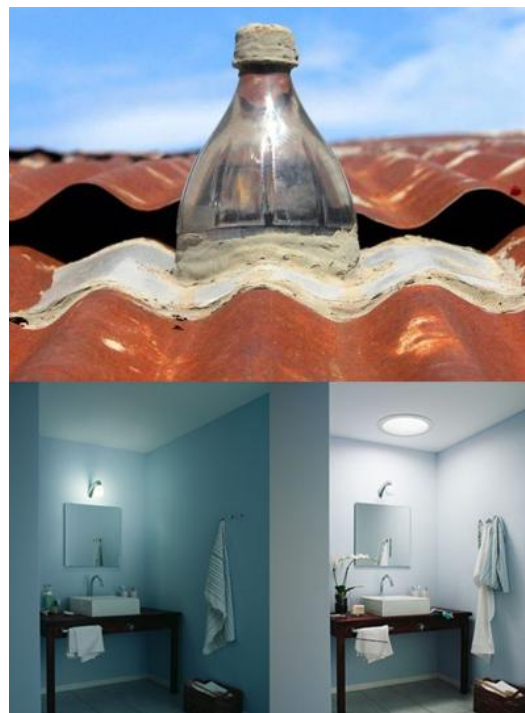
Fig. 11 – Prima e dopo. Un foro al soffitto, diviene l'alloggio per una bottiglia (ermetica e stagna) per il raggiungimento della luce nel sottostante ambiente (camino di luce).
